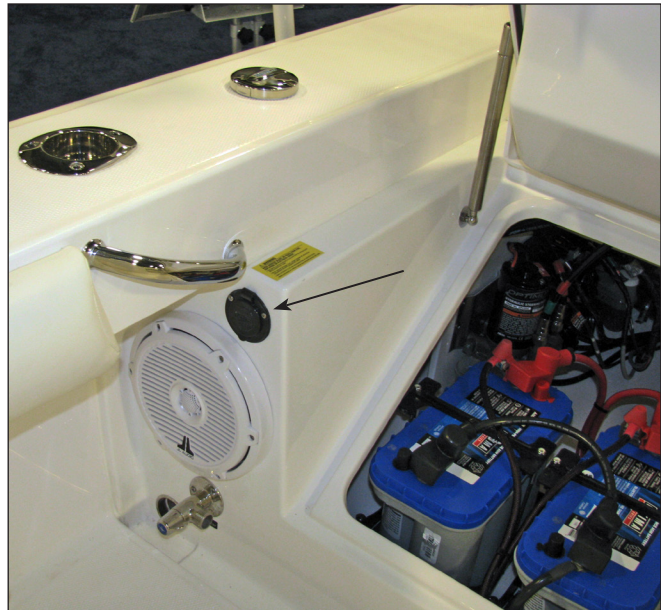
120 Volt Shore Power Inlet Connection
